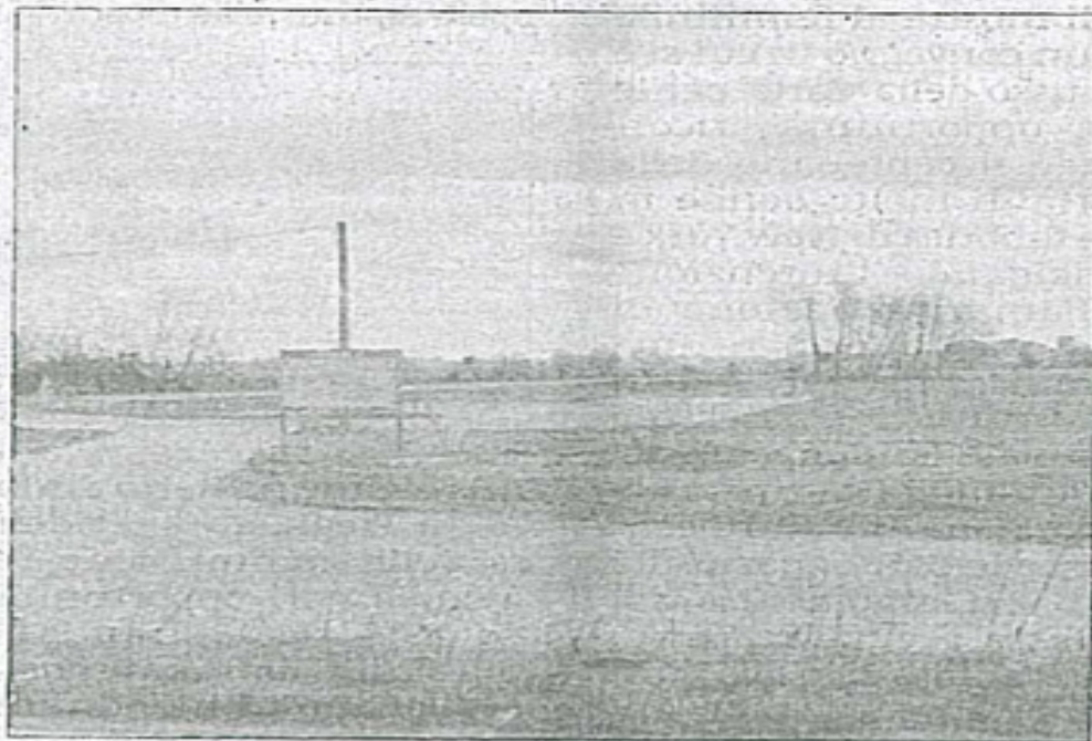
I lavori in corso L'area che riguarda il comune di Gavello
